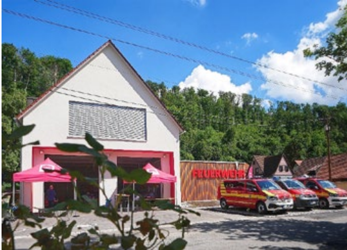
Das neue Gerätehaus
